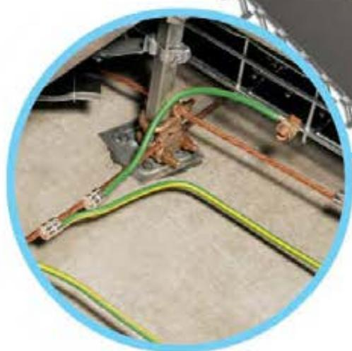
Das QuickNet™-Kupferverkabelungssystem wird zur Optimierung der Netzwerkleistung in das Panduit™ StructuredGround™-System integriert
