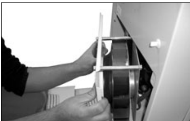
Fig. 49: Remove the fan
